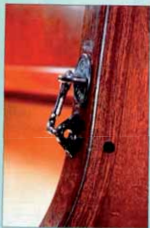
Un filoir en plastique évite au crochet de porte de faire du bruit.
