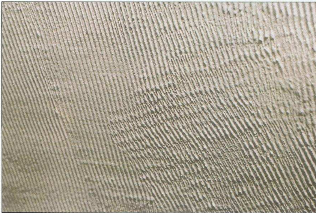
Photo 2-13 : système BRIGNOLA : aspect après passage de la 1ère couche à la spatule crantée
