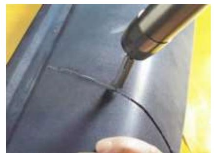
*L'agrafage linéaire avec la buse de pointage permet de réunir et réaligner les parties cassées de l'élément à réparer avant le soudage proprement dit.*
