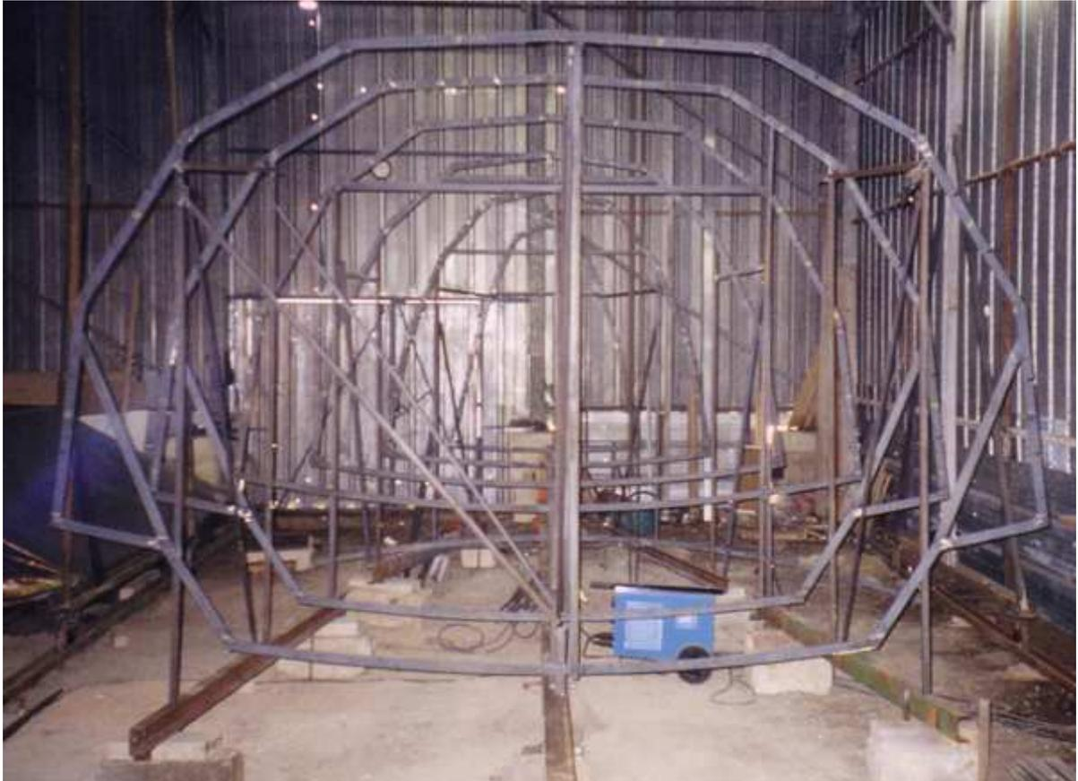
Quand les couples sont posés sur le châssis (à IPN central), les barrots sont déjà terminés, non entaillés car les lisses de pont n'y sont pas encastrées. Seules les cadènes n'y sont pas car elles compliquent la pose des tôles.
