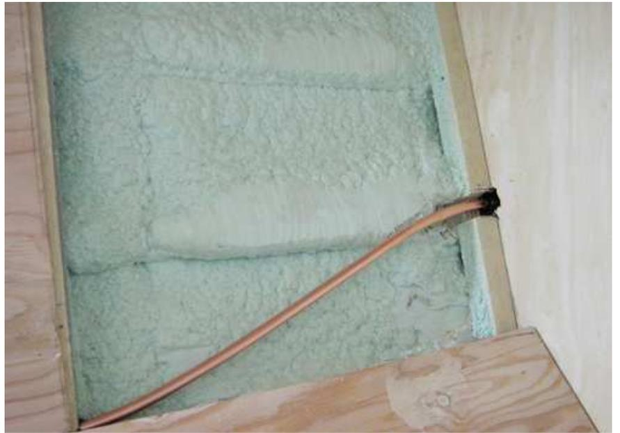
Ici, sur Impermanence, la mousse a été projetée sous pression, ce qui a permis de poser les cloisons avant. Cette méthode ne donne plus un accès aisé au métal en cas de sinistre.
