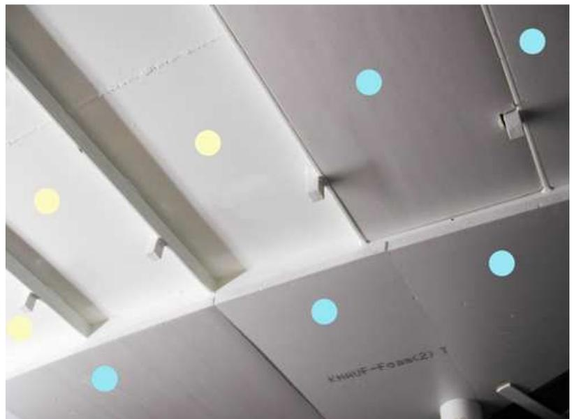
Isolation avec des plaques de mousse de polystyrène expansé ignifugé. Souvent de couleur bleu clair, elle est ici grise. Les points bleus désignent les zones isolées. Les points jaunes, celles qui ne le sont pas encore.
