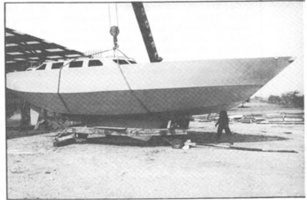
**Photo D 60 : Cette coque pontée est livrée avec ses peintures de protection. Il peut rester ainsi plusieurs mois.**
